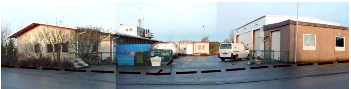
Befintlig lastgård. Ny gräns mellan fastigheterna markerad
