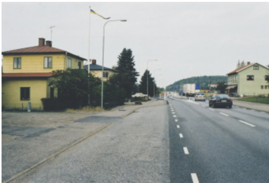
Hastighetsdämpande port på E6:an.
