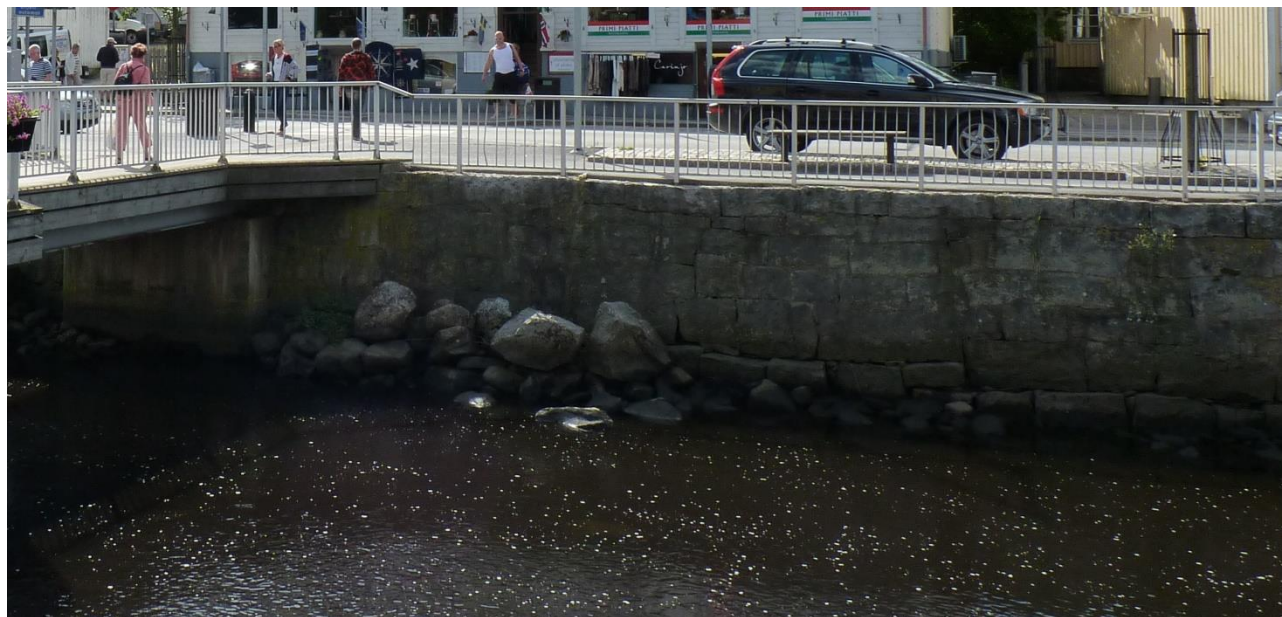
Del av den murade kajkanten utmed Södra Hamngatan
