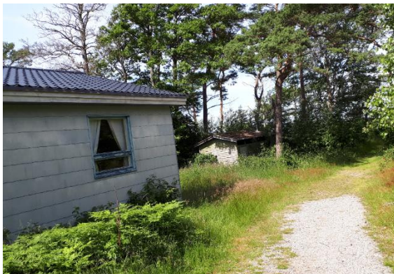
Befintliga byggnader. Område 2 gränsar till gångstig som leder vidare till reservatet i norr.
