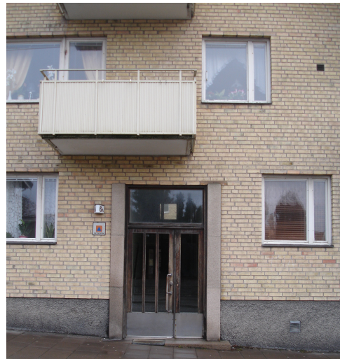
Foto från Surbrunnsgatan Port, fönster, balkong i original utförande från 60-talet
