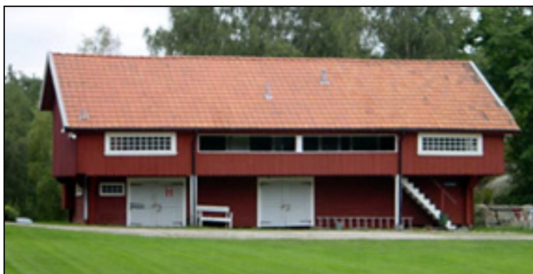
Bild 12. Befintlig loftbod, den sk Ornässtugan.
