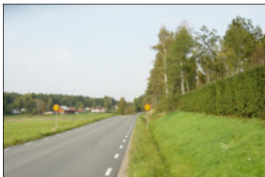
Slänt/sluttning mot väg 1034
