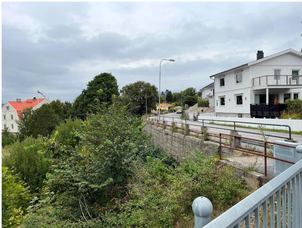
Befintlig mur utmed Surbrunnsgatan mot Pilen 6 och 7
