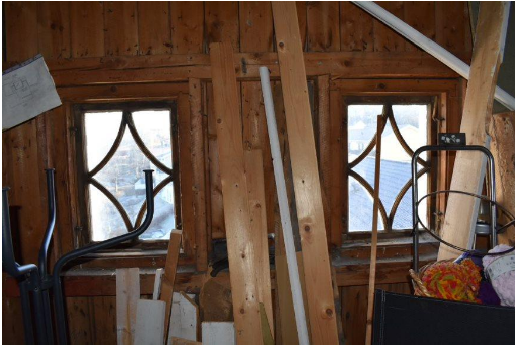
De två spröjsade nockfönstren på den nordöstra gavel är byggnadens enda kvarvarande äldre fönster.
