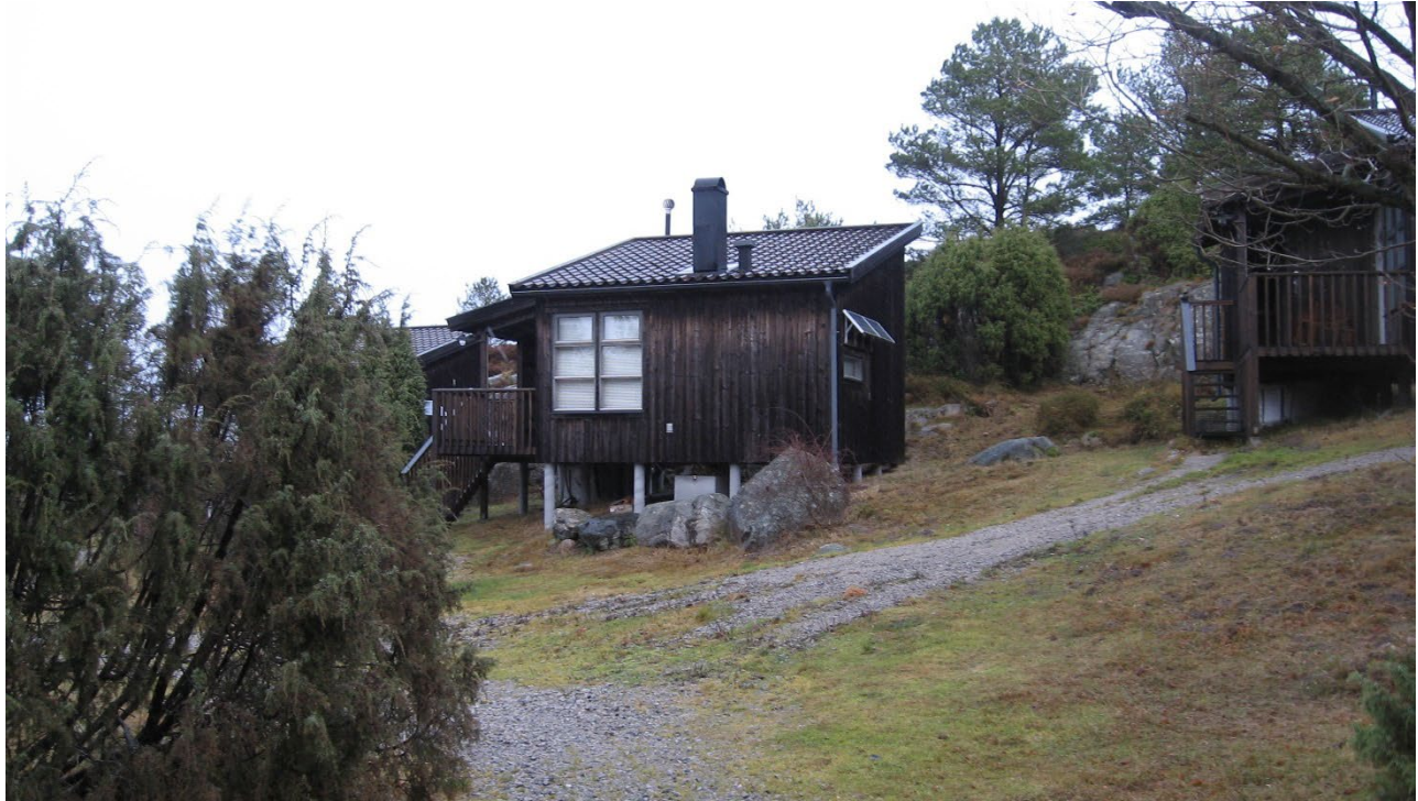
Exempel på grundläggning av campingstugor på pålar för att undvika sprängning. Bild från camping i Reservatet Nordkoster.
