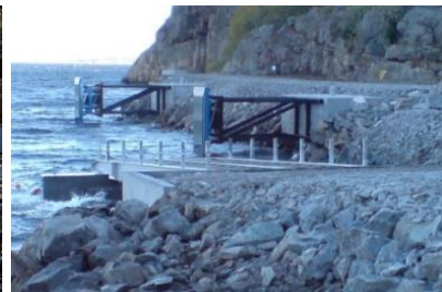
Kajläge med ro-ro-ramp.
