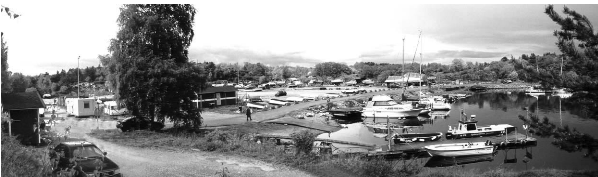
I gränsen mellan grusplanen och småbåtshamnen är en sprängstensbank ner till fast botten anlagd. Vattendjupet är 9 meter i hela småbåtshamnen.
