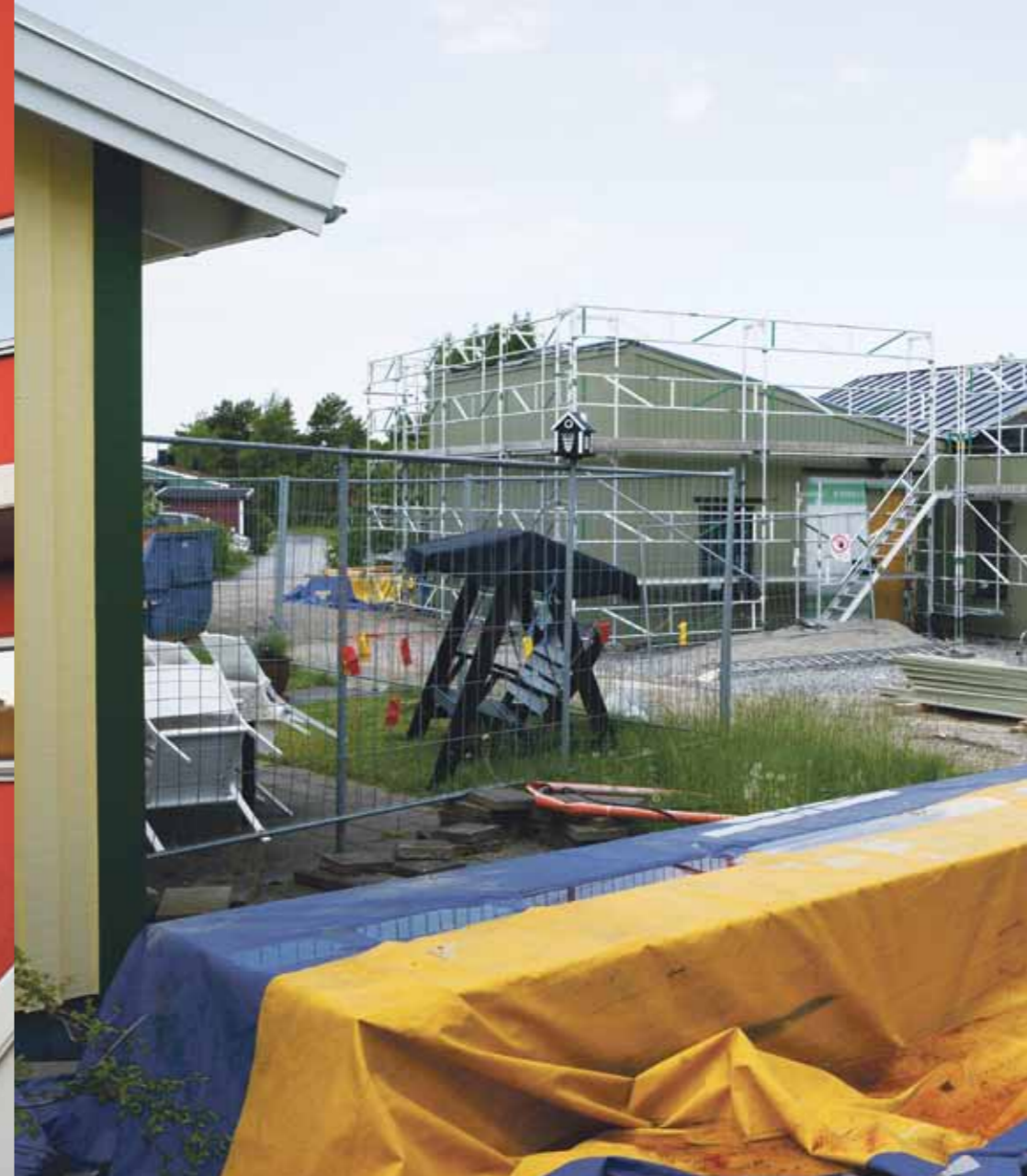
Ungdomsboende på Solbo – byggnation pågår.
