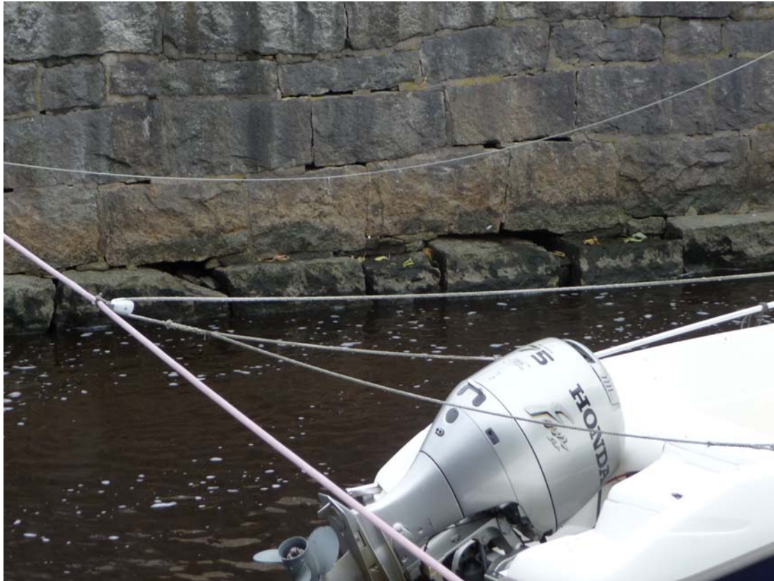
BILD 10. Tecken på underminering vid småbåtsbryggor
