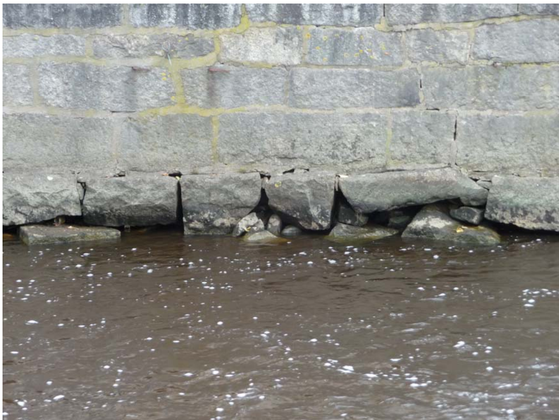
BILD 5. Horisontella spalter under hugna block
