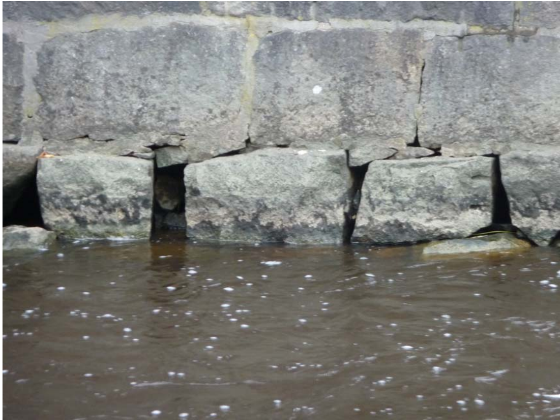
BILD 4. Vertikala spalter mellan block
