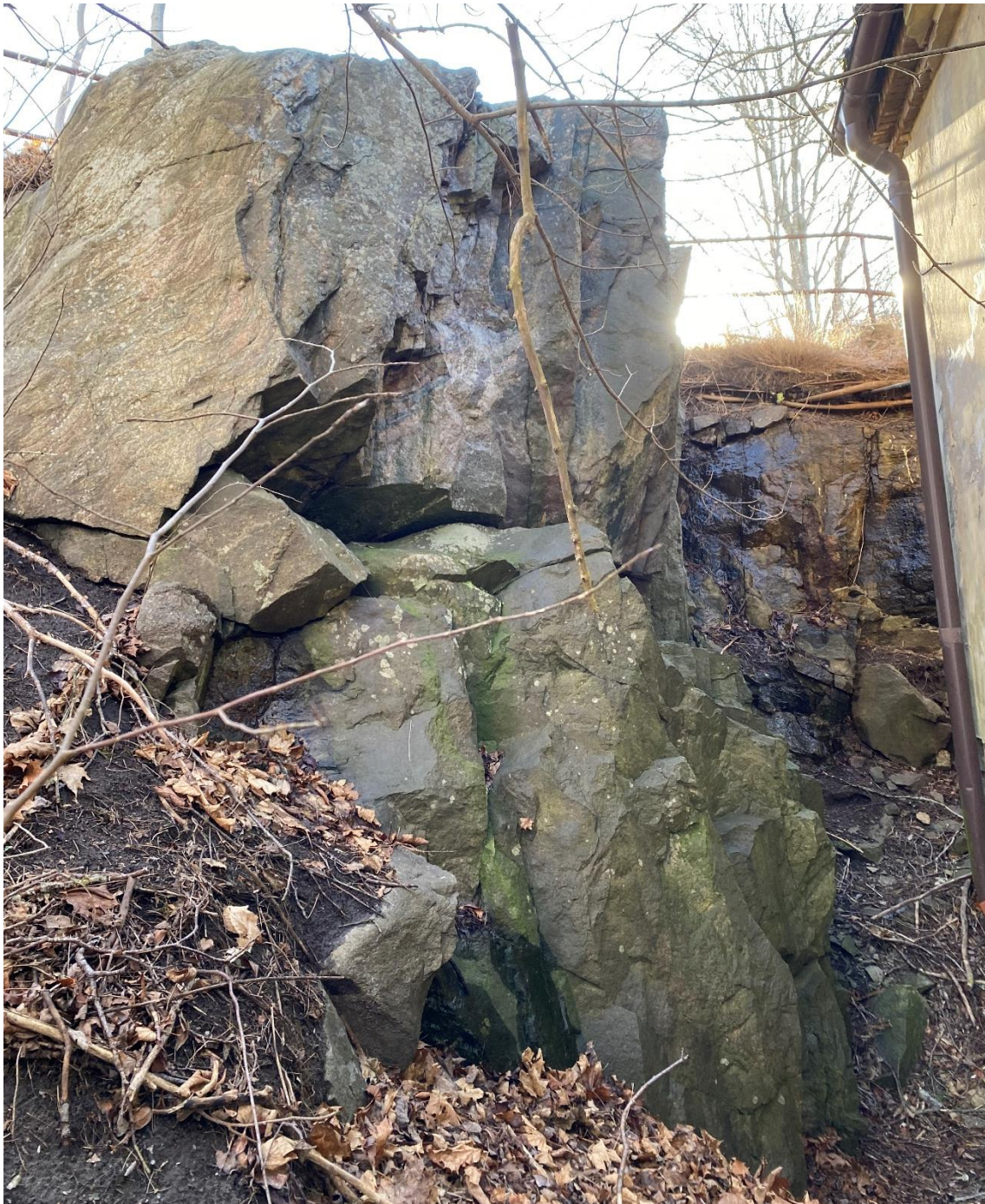
Figur 7 Visar framschaktad bergsslänt invid SÖ hörn på områdets enda byggnad. Bild mot öst.
