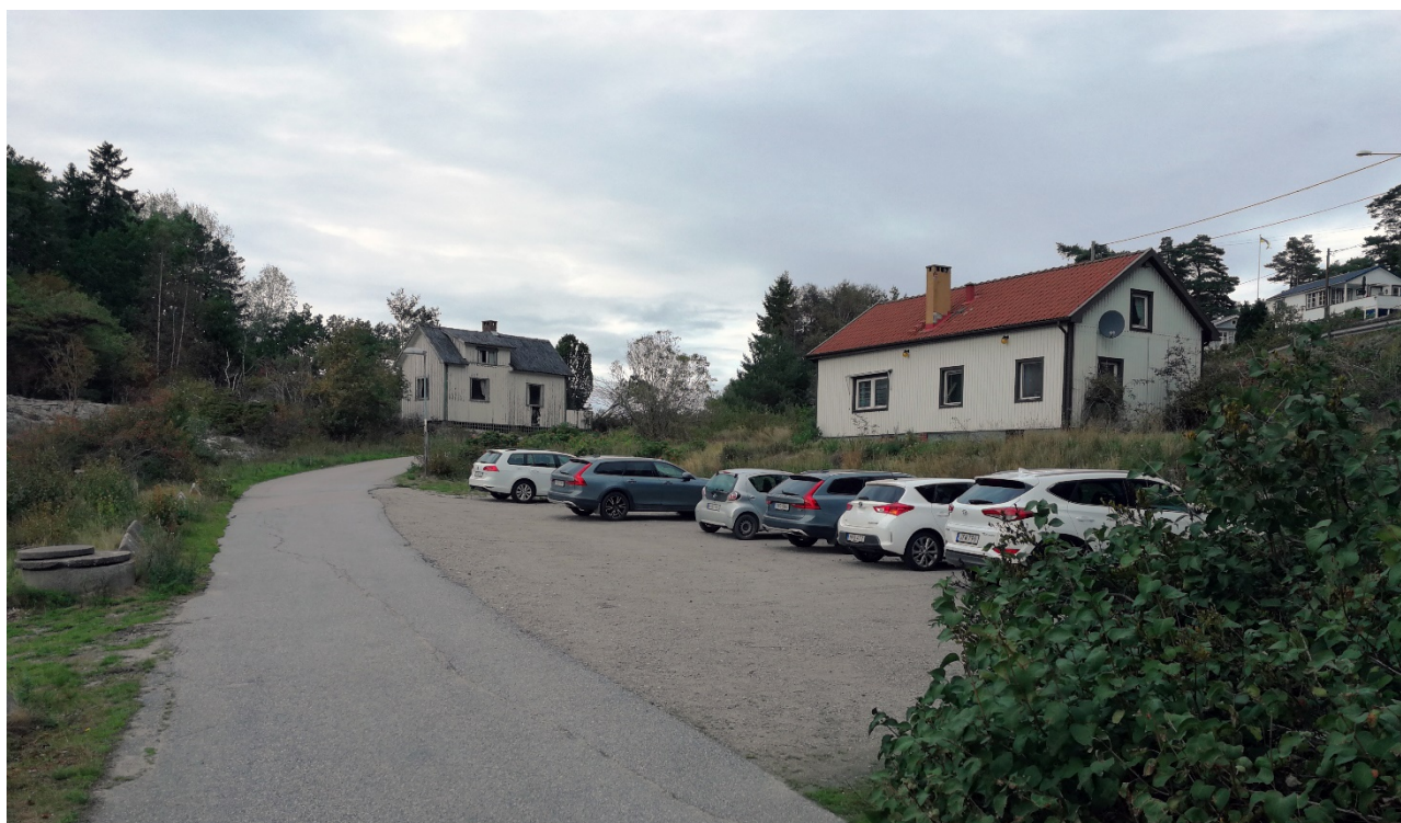
Två av de obebodda bostadshusen i den norra delen av planområdet
