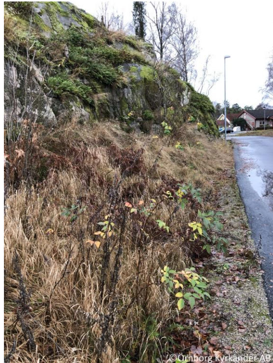
Figur 8. Enstaka plantor växer i området precis intill väg.
