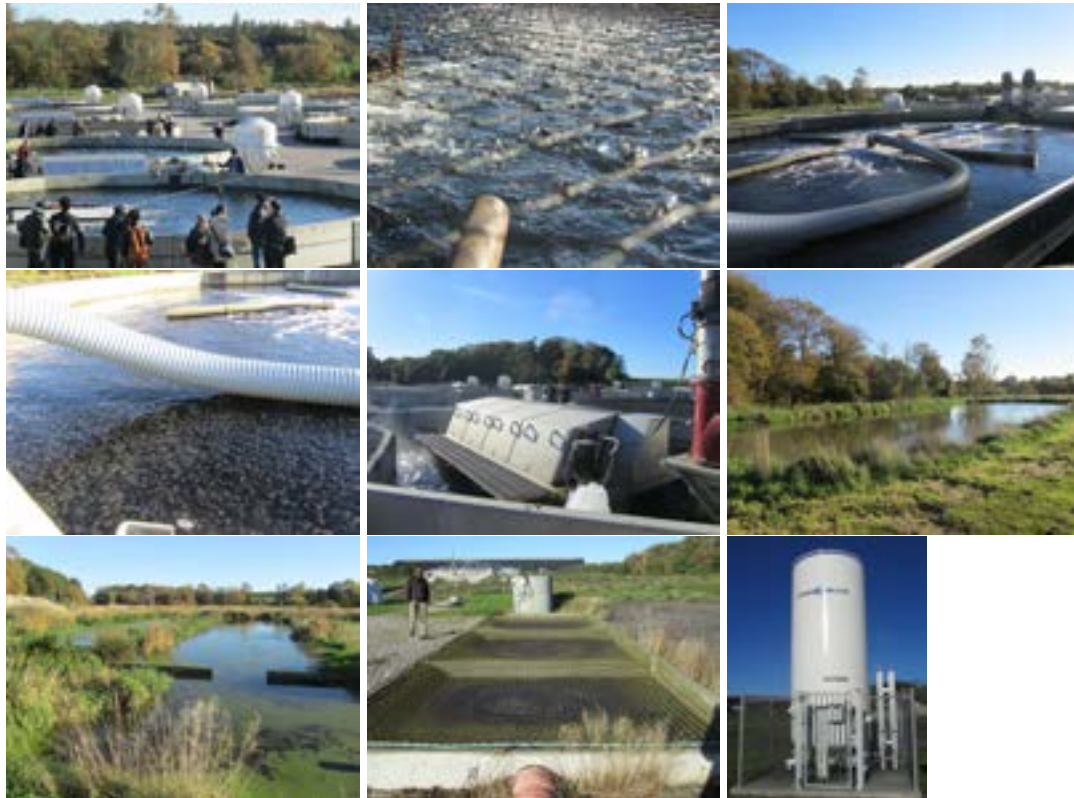
Figur 28. Lerkenfeldt öringfarm oktober 2013. a) översikt anläggningen, b) matning av fisk m.h.a lufström, c) biofilter, d) komponenter i biofilter synliga, e) trumfilter, f) sedimenteringsdamm, g) våtmarker bestående av gamla dammarna, h) avdunstning slam, i) syremagasin. Foto: Anette Ungfors.
