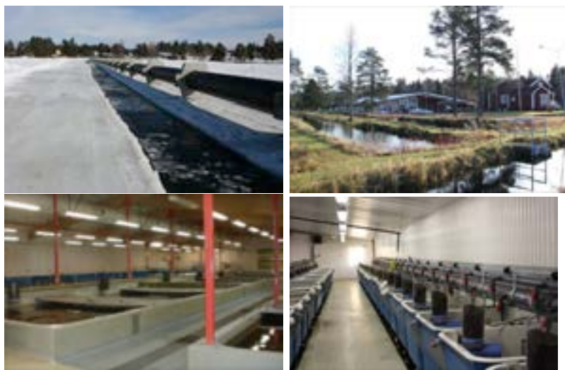
Figur 31. Kälarne forskningsstation. a) förlängning av intagstub från sjö år 2010, b) stora hallen och dammar i förgrunden, c) stora hallen med betongkar, d) lilla hallen med 1m 3 -plastkar. Foto från Daniel Wikberg.
