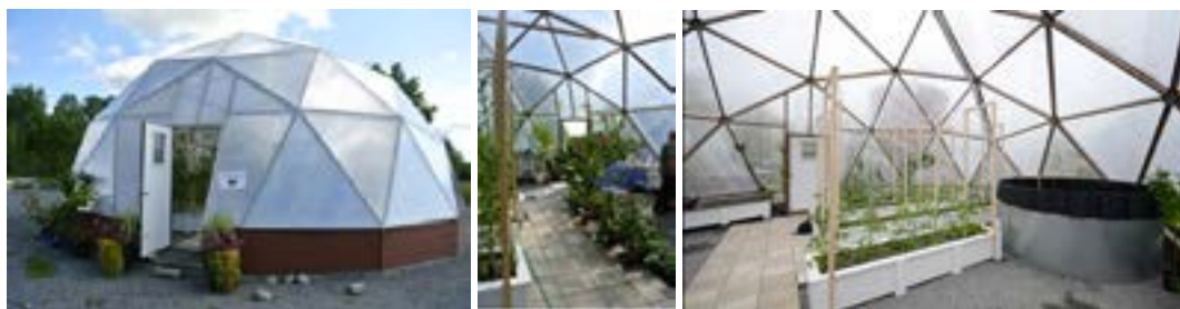
Figur 23. Växthuset, Berga naturbruksgymnasium, a) 80 m 2 stort kupolformat växthus, b) fiskkaret till höger, c) inne i växthuset frodas det.
