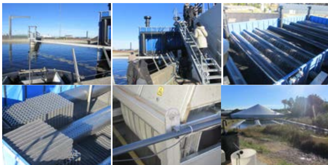
Figur 27. DTU aqua foton vid studiebesök oktober 2013, saltvattenPRAS. a) fiskkar av betong, b) trappa upp mot reningsdelen, c) avgasning, d) närbild tricklingsfilter utan strilning, e) trumfilter, f) sedimenteringsbassäng. Foto: Anette Ungfors.
