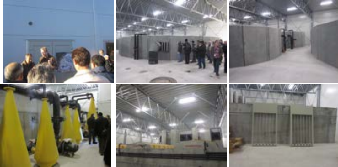
Figur 19. Studiebesök Danish Salmon oktober 2013. a) ägare berättar om bygget och finansiering, b) stor bassäng håller på att byggas klar, c) något mindre bassänger, f) syrekoner, g) mekaniska filter, h) UV-ljus som ska monteras. Foto: Anette Ungfors.
