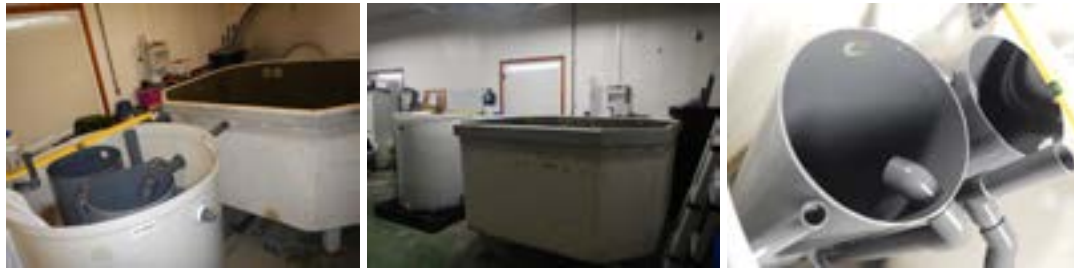
Figur 48. Foton på försökskaret och reningsutrustning under montering. Foto: Anette Ungfors.
