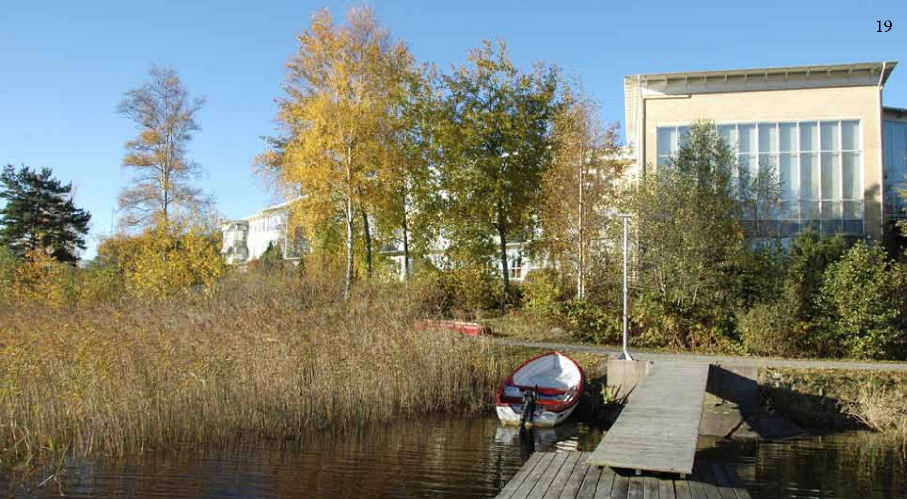
Strömstad gymnasium. Foto: Göran Boman
