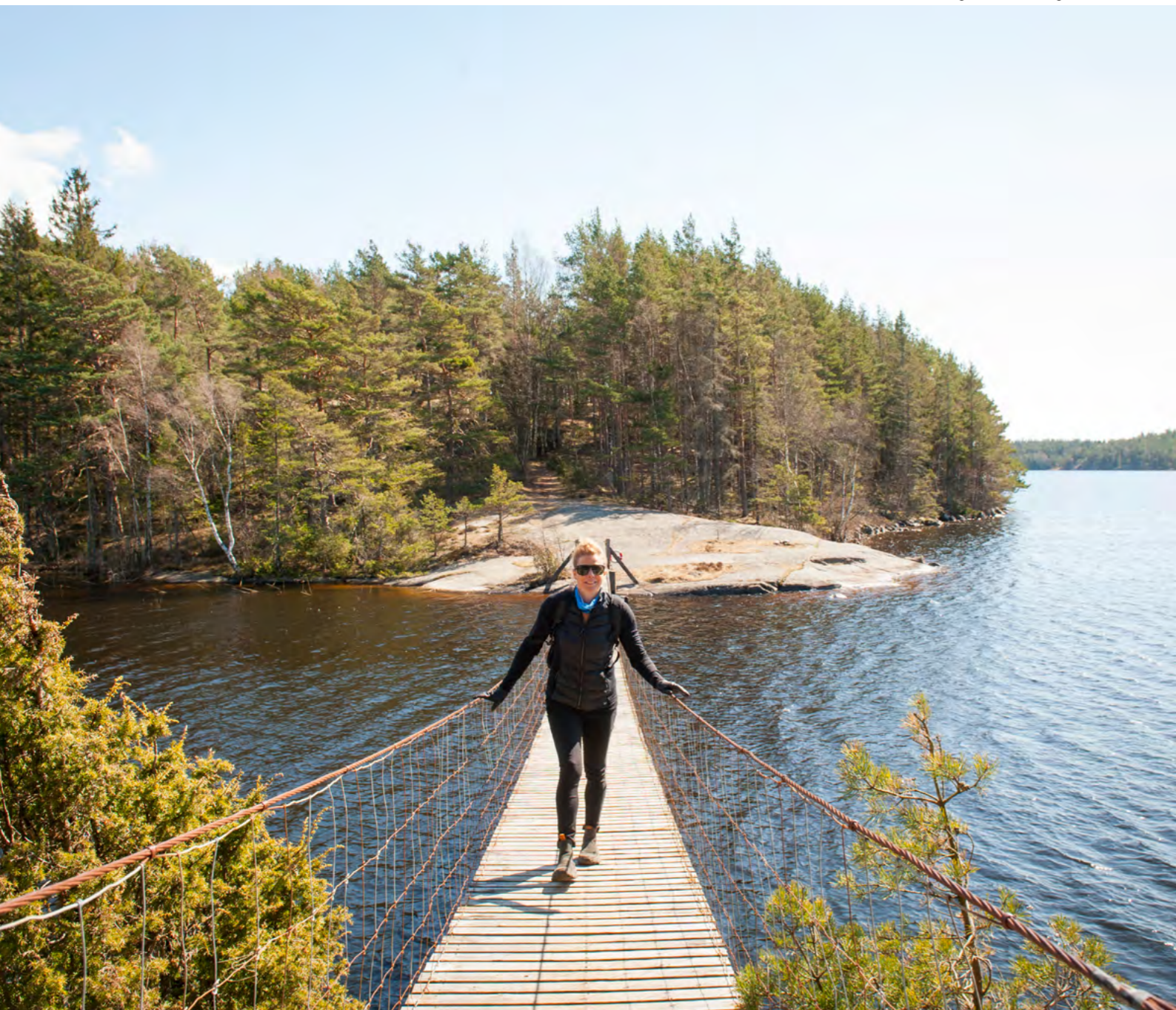
Hängbron vid Färingen
