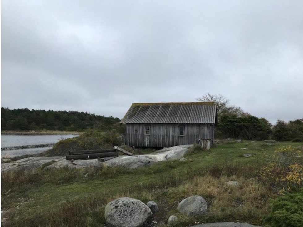
Förrådsbyggnad utanför fastigheten Korsnäs 2:106
