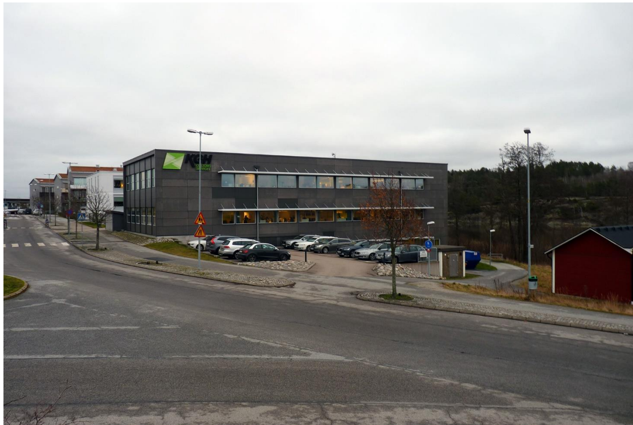
Kontorshuset på Kaveldunet 1 med parkering. Till höger skimtar roddmagasinet, mellan byggnaderna gångvägen.
